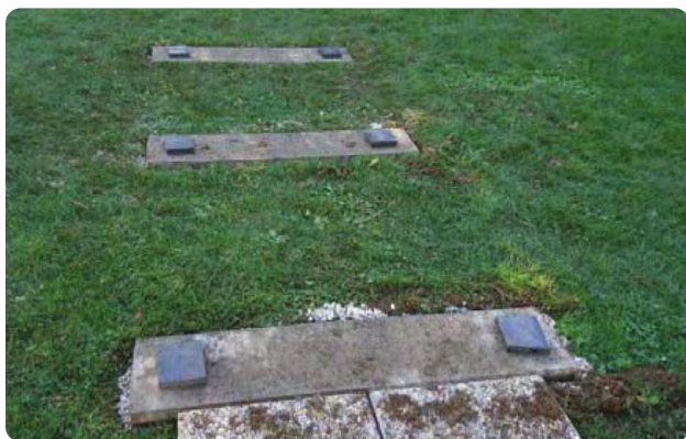
Betónové platne pod podperami
